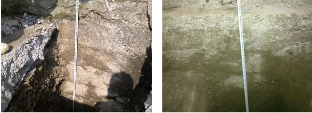
Şekil 4. Binanın dışından ve içinden açılan temel çukurları
