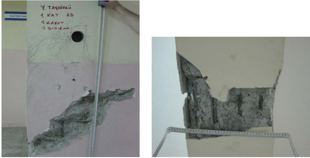
Şekil 2. Kolonlarda ve kirişlerde sıyırma işlemi yapılması.
